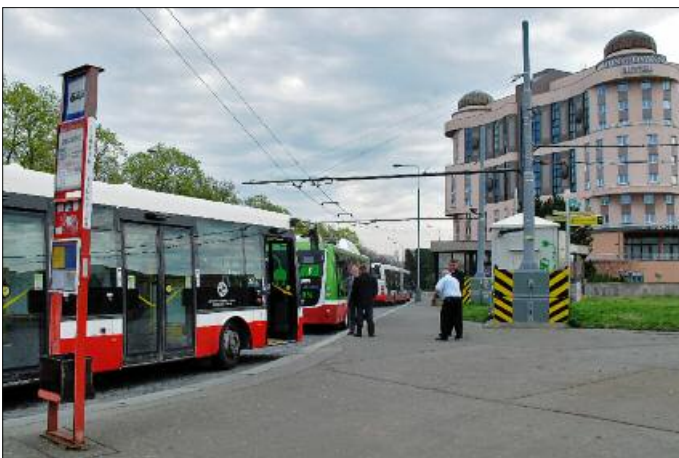
12. Das kurze Stück zweipoliger Fahrleitung wird mit 750 V DC gespeist.
