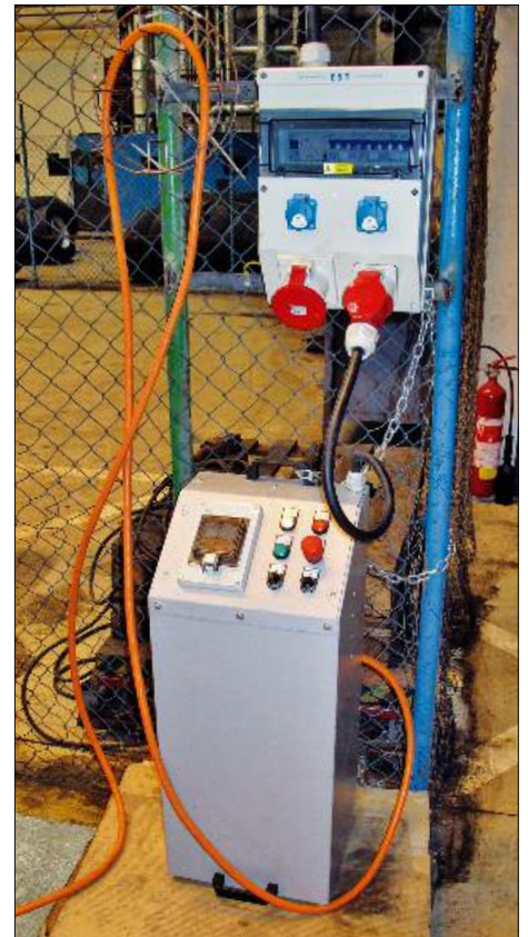
18. Ladegerät mit 440 V 3AC in der Garage Hostivar
